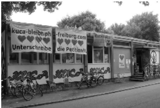
Abrissbedroht: Der Pavillon, in dem Studierende seit den 80er Jahren das KuCa betreiben.
